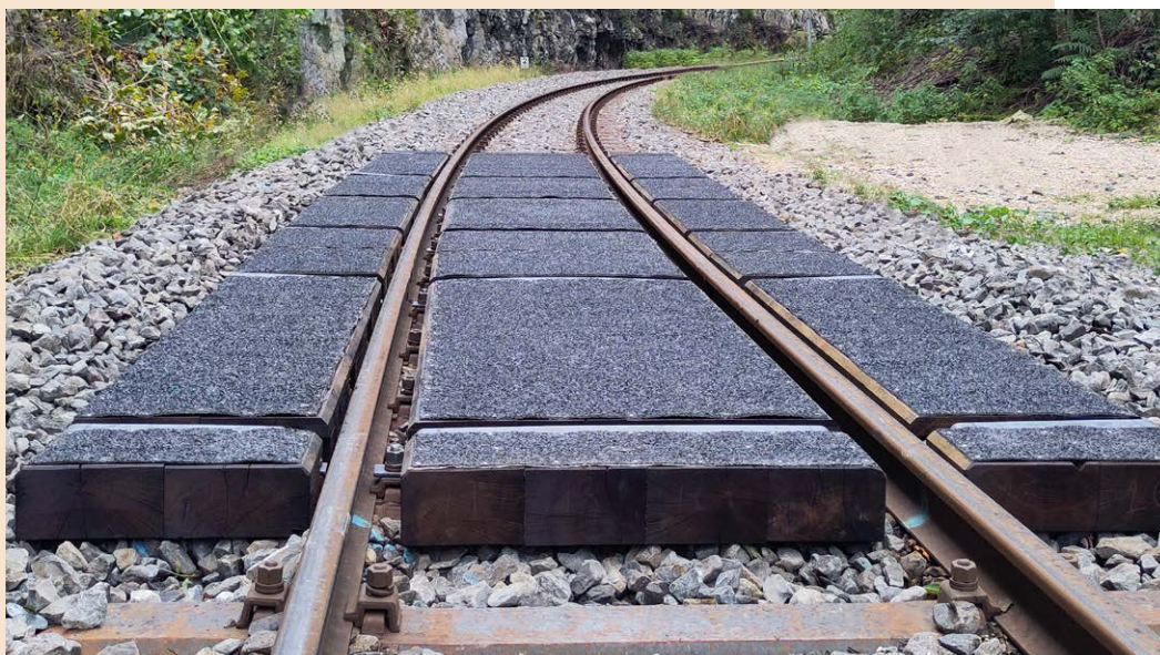
Bahnübergang, Les Brenets
