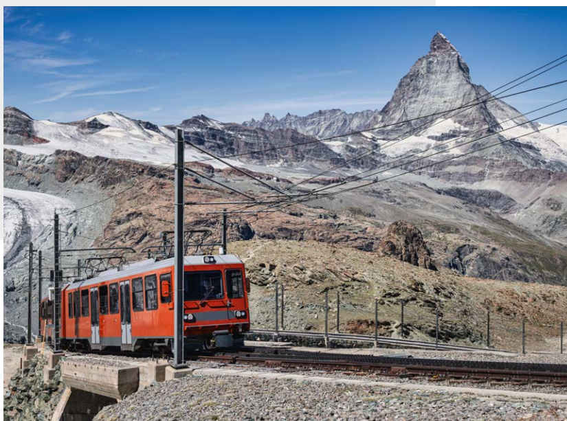
voie à crémaillère, Gomnergratbahn
