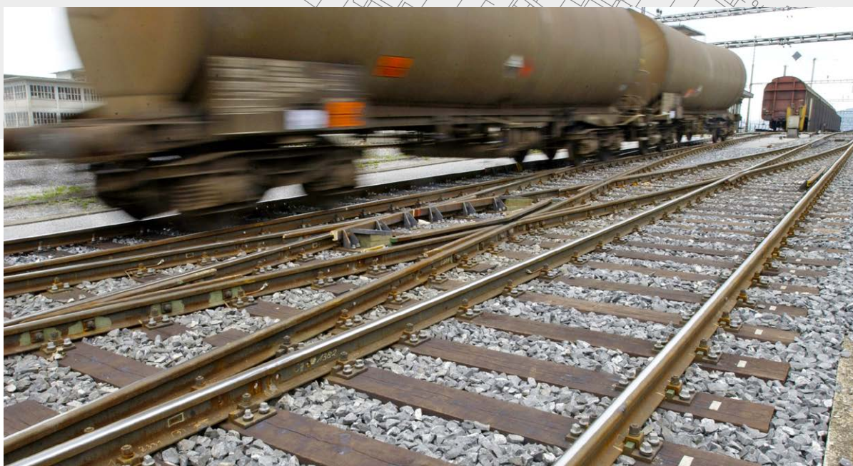
voie d'aiguillage, MuttENZ
