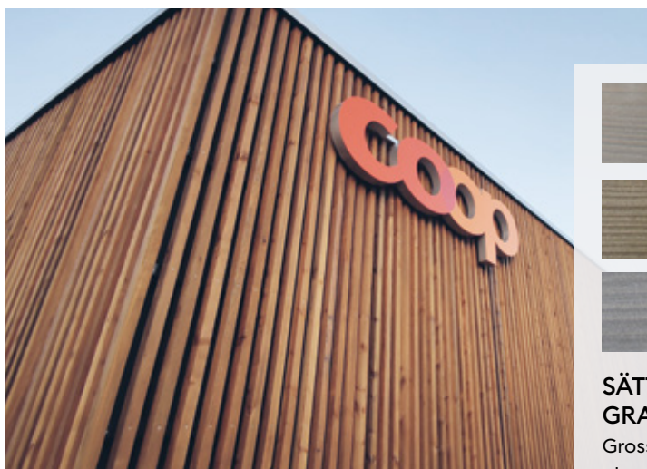
Weisstanne Fassadenkanteln, mit braunem Salz imprägniert + Sättiger
