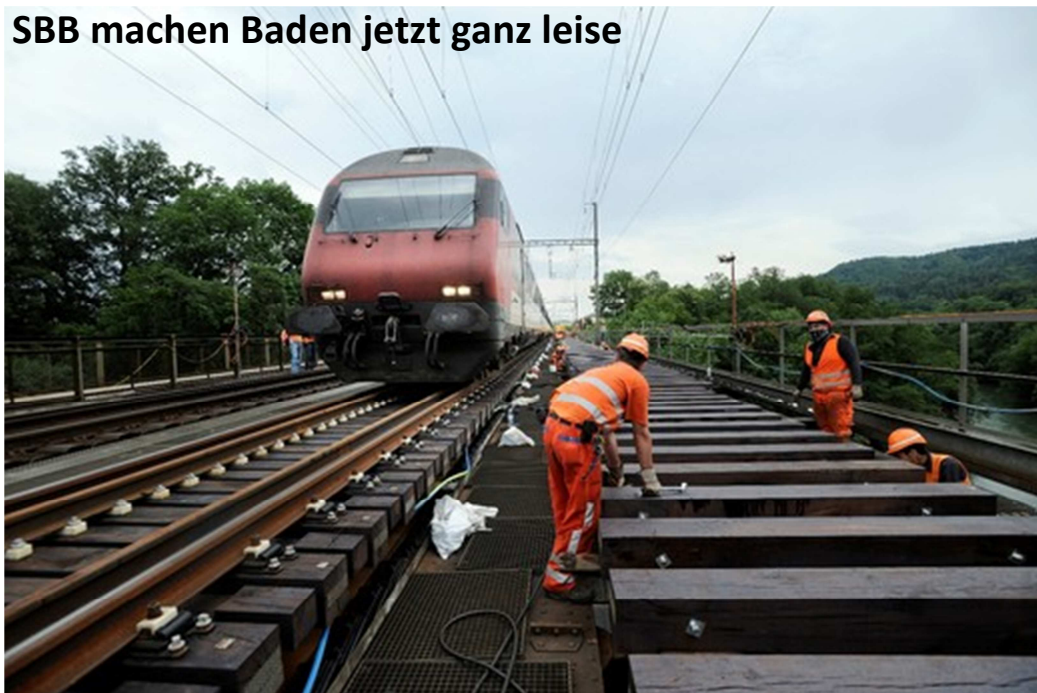
Lärmsanierungsarbeiten an der Eisenbahnbrücke zwischen Baden und Wettingen.
